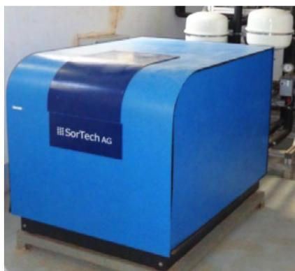
Machine à adsorption
